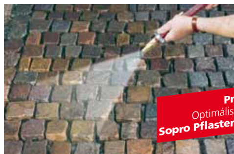
A megtisztított kifugázandó burkolat előnedvesítése
