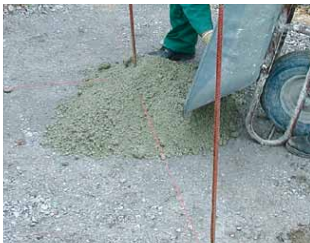
A Sopro DrainageMörtel felhordása az előkészített felületre
