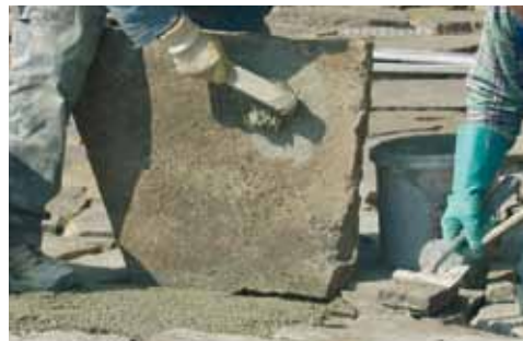
A Sopro HaftSchlämme Flex felhordása a poligonál lapok hátoldalára
