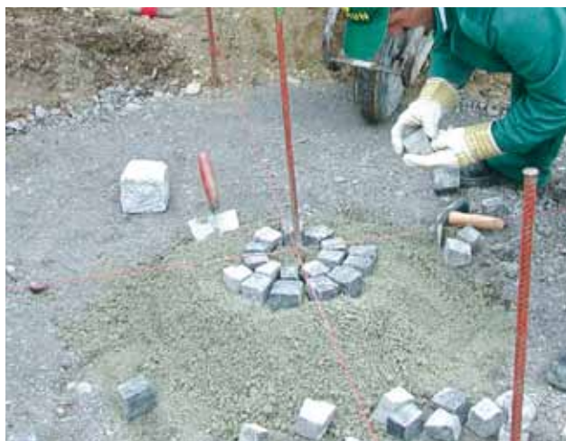
A hátoldalukon Sopro HaftSchlämme Flex-szel bevont térkövek elhelyezése a tömörített Sopro DrainageMörtel ágyazatban
