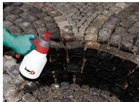
Sopro Pflaster-Fughilfe-vel előkezelt térkő burkolat
