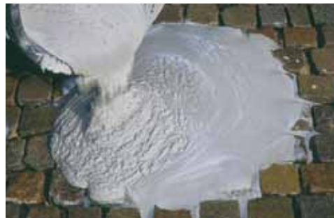
Bedolgozásra kész Sopro EpoxiPflaster-Fuge 2-K
