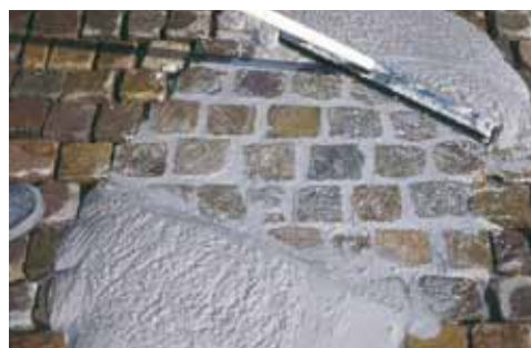
Sopro EpoxiPflaster-Fuge 2-K bedolgozása
