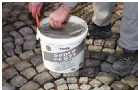
Sopro 1-K PflasterFuge vákuumfóliájának felnyitása
