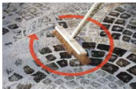
A kifugázott burkolat tisztítása
