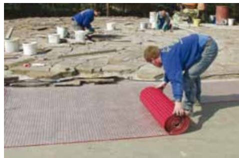
Sopro DrainageMatte kiterítése a lejtés irányára merőlegesen a Sopro DichtSchlämme Flex 1-K-val előkészített felületre
