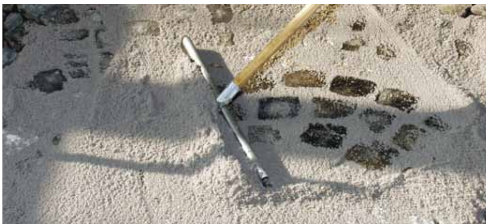
Sopro flaszter fugázó anyagok felhordása
