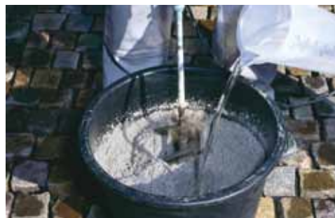
Sopro EpoxiPflaster-Fuge 2-K-hoz 2 l víz hozzáadása
