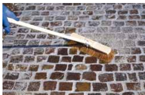
A kifugázott burkolat tisztítása
