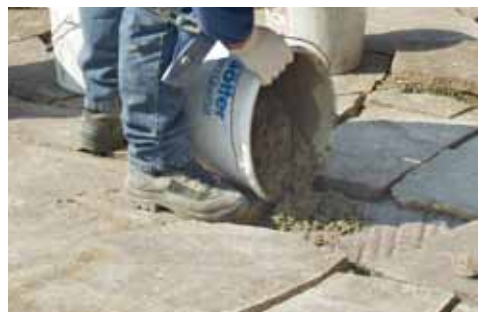
Sopro DrainageMörtel felhordása
