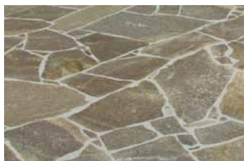
Kész kifugázott burkolat
