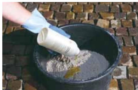
Sopro EpoxiPflaster-Fuge 2-K-hoz térhálósító hozzáadása
