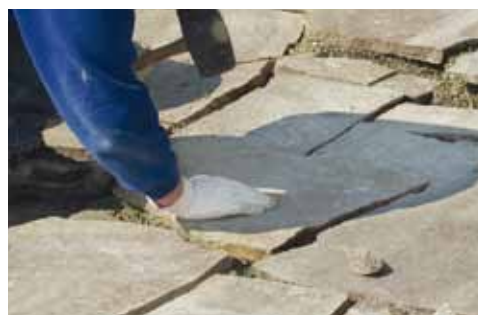
A lapok elhelyezése az átszivárogató habarcsba
