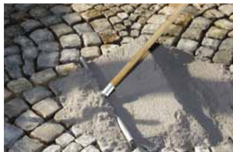
Sopro 1-K PflasterFuge bedolgozása
