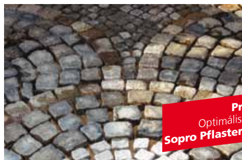
Megtisztított, száraz fugázandó burkolat
