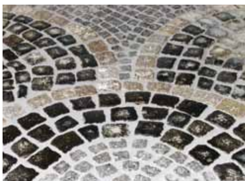
Térkő burkolat fugázó anyag maradványokkal
