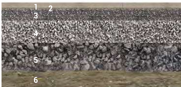
Abbildung 4: Aufbau gebundene Bauweise (Oberbau 1–5)
