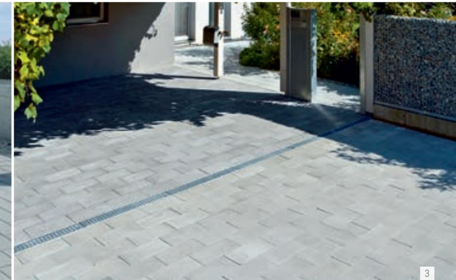
Die Sachlichkeit des modernen Wohnbaus findet mit diesen Steinen in der Pflasterung ihre Fortsetzung. Die SIGMA VG4 Pflastersteine und Pflasterplatten sind scharfkantig ausgeführt, dadurch wirkt das Fugenbild schmäler. Die eleganten Grau- und Edelsplittfarbtöne, in der die SIGMA VG4 Pflasterplatte zur Verfügung steht, verleihen Eingängen, Einfahrten, Terrassen und Innenhöfen einen zurückhaltenden aparten Touch.
