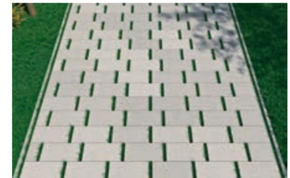
LINEA VG4 Pflasterplatte 60 x 30 x 8 cm im Drittelverbund mit einer vertikalen Fugenbreite von 55 mm verlegt.
