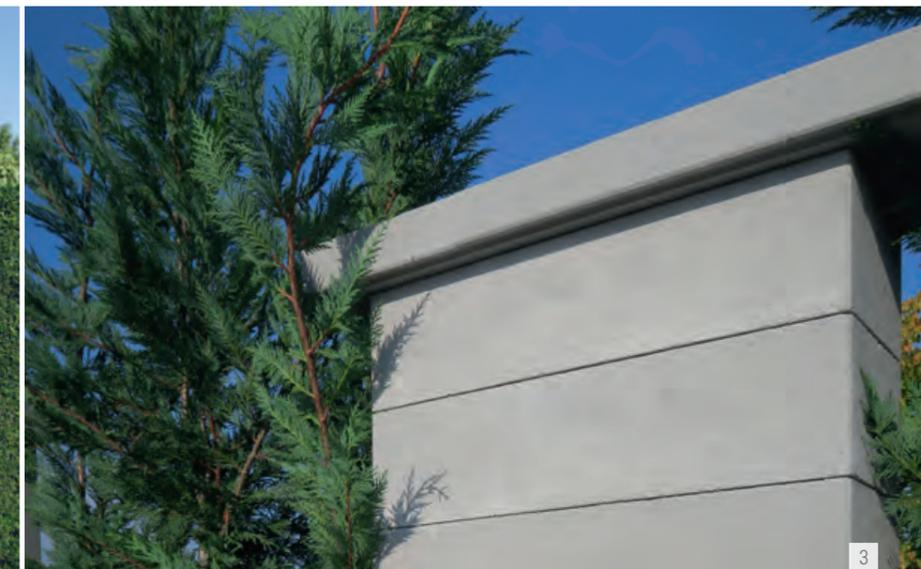
Der LINEA ZAUN- & MAUERSTEIN überzeugt durch seine schlichte Moderne. Das extravagante, längliche Format passt sich jedem Baustil an und ist in den verschiedensten Architektur- und Anwendungsbereichen vorzufinden. Das Linea Zaunsystem besteht aus einem Universalstein, verschiedenen geschnittenen Passsteinen und einer Abdeckplatte mit Wassernase.
