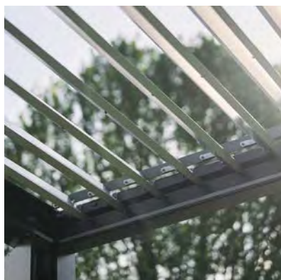
01 Kézzel állítható lamellák
