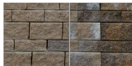
Kerítés hidrofobizált anyagból
