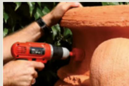
Der Behälter erhält eine Bohrung für die Montage der Zulaufdichtung.
